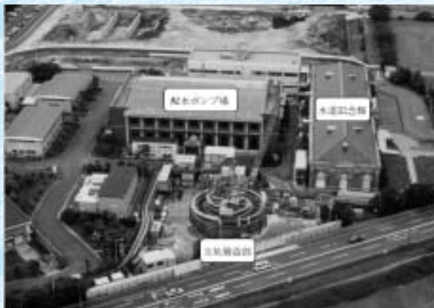
写真1 柴島立抗施工状況
