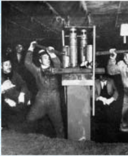
写真2 地盤支持力の試験
