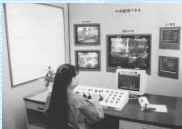
写真6 ケーソンショベルの地上遠隔操作状況
