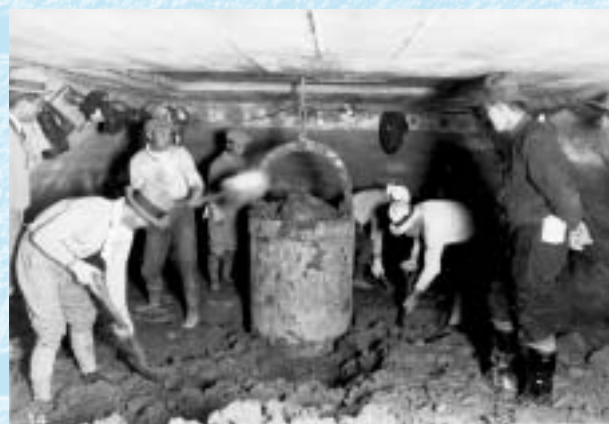
写真1 人力掘削状況
