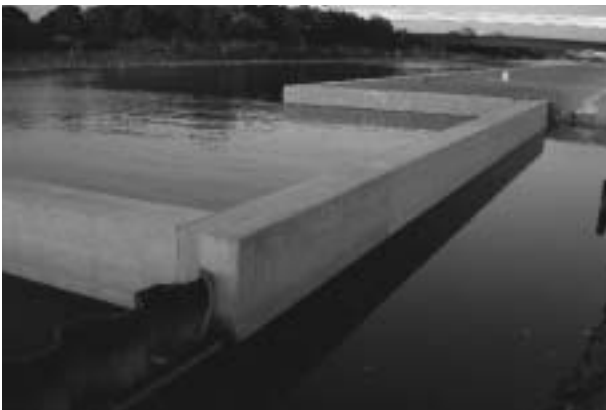
写真1 自立式護岸暫定時
