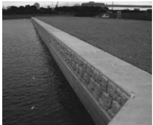
写真3 控え式直立護岸完成時
