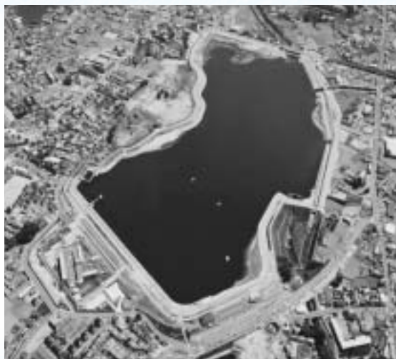
改修工事完成後の狭山池（写真提供：上下とも大阪府土木部河川室ダム砂防課）
