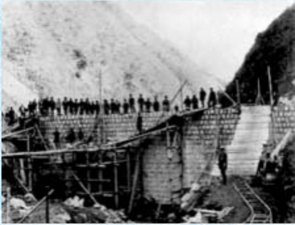
日本最古のコンクリートダムである五本松ダム（布引ダム）の建設当時の写真（出典：土木学会附属土木図書館「土木貴重写真コレクション」）
