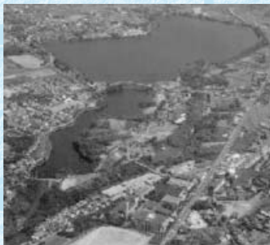
日本最古のため池 狭山池（工事前）
