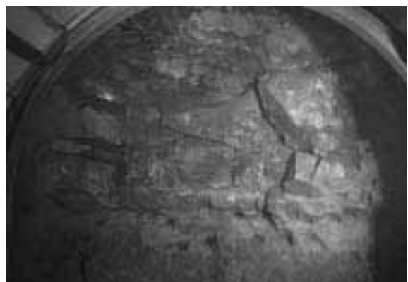
写真4 切羽の硬質砂岩
