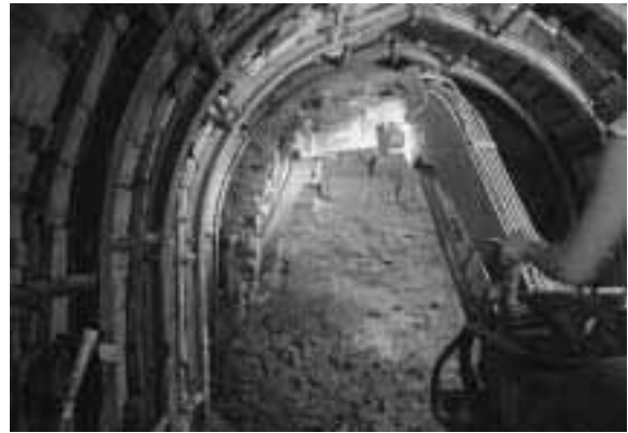
写真3 ブレイカーによる掘削状況
