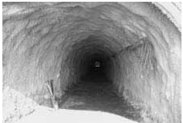
写真6 施工完了後のトンネル内部
