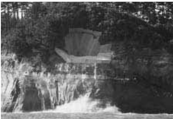
写真5 施工完了写真
