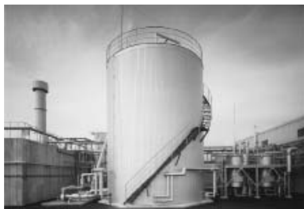
写真 400m 3 メタン発酵槽
