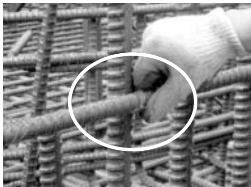
結束線余長の内側折込み状況
