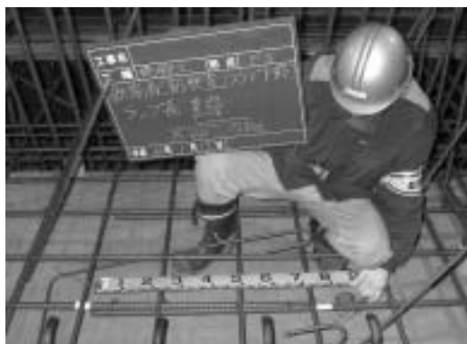
重ね継手長検査例
