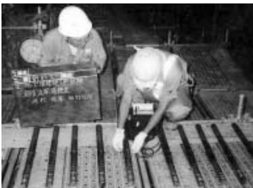
施工前技量検査例 (超音波試験)
