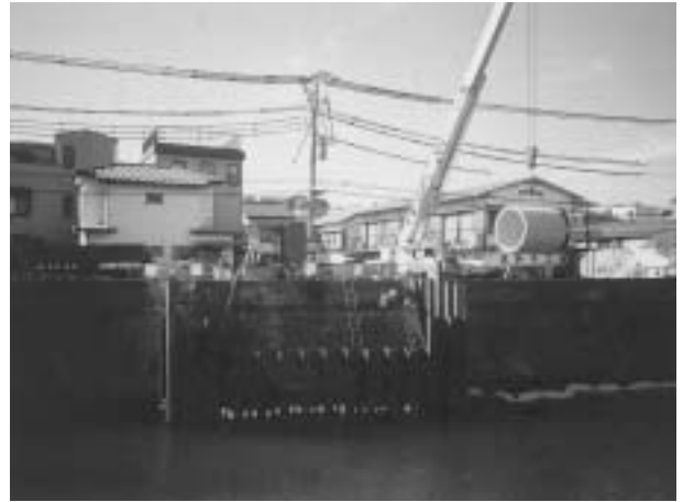
写真8 推進管吊込状況
