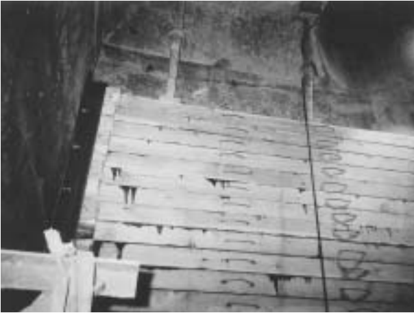
写真5 人孔部角落し設置
