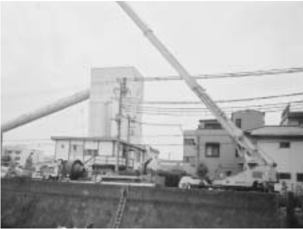
写真7 刃口吊込状況
