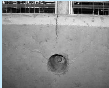
セパ上の沈下ひび割れ例
