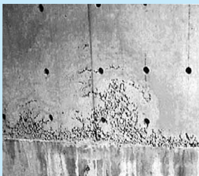
壁部ジャンカ例*2
