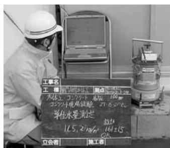
受入検査状況 (単位水量試験)
