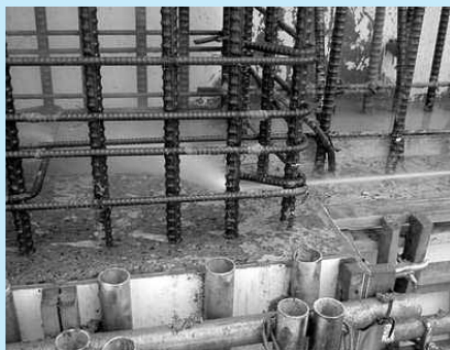
水平打継レイタンス処理例 (遅延剤+ジェット水)
