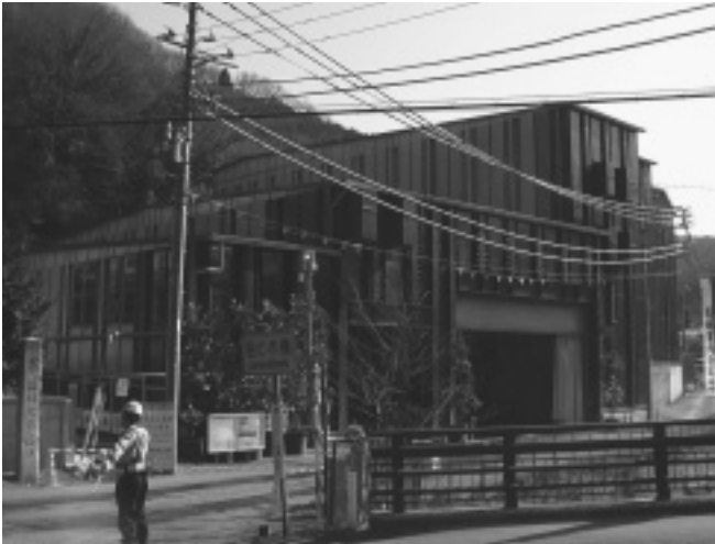
写真2 作業基地外観
