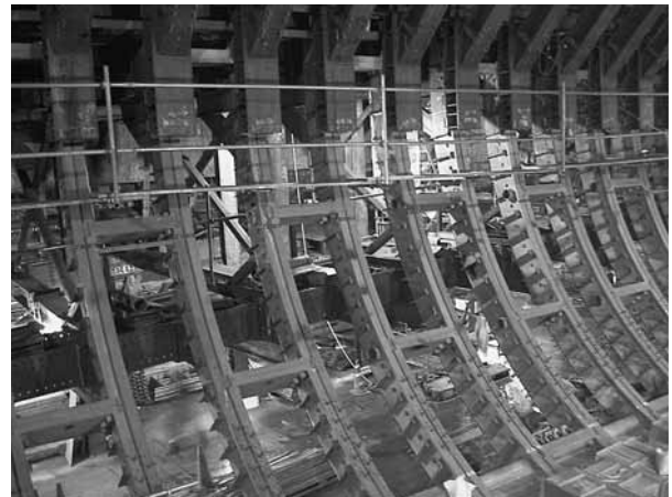
写真4 シールド切開き状況
