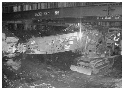
写真 1 カッターローダ掘削状況
