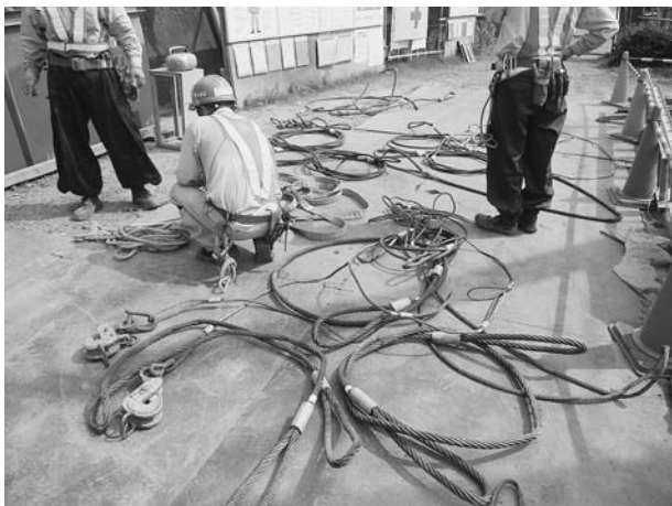
作業前点検(ワイヤロープの点検)
