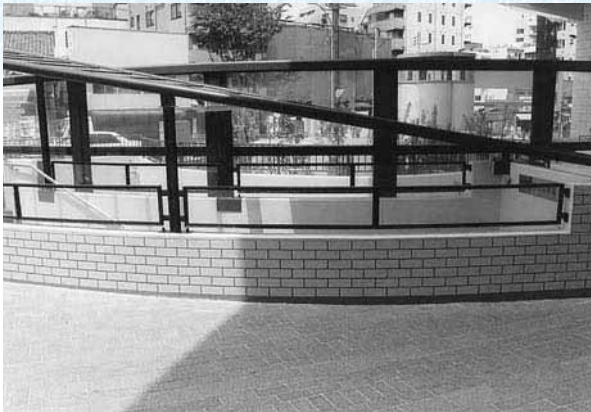
写真6 地下道の壁高欄に樹脂系型枠式タイル施工例
