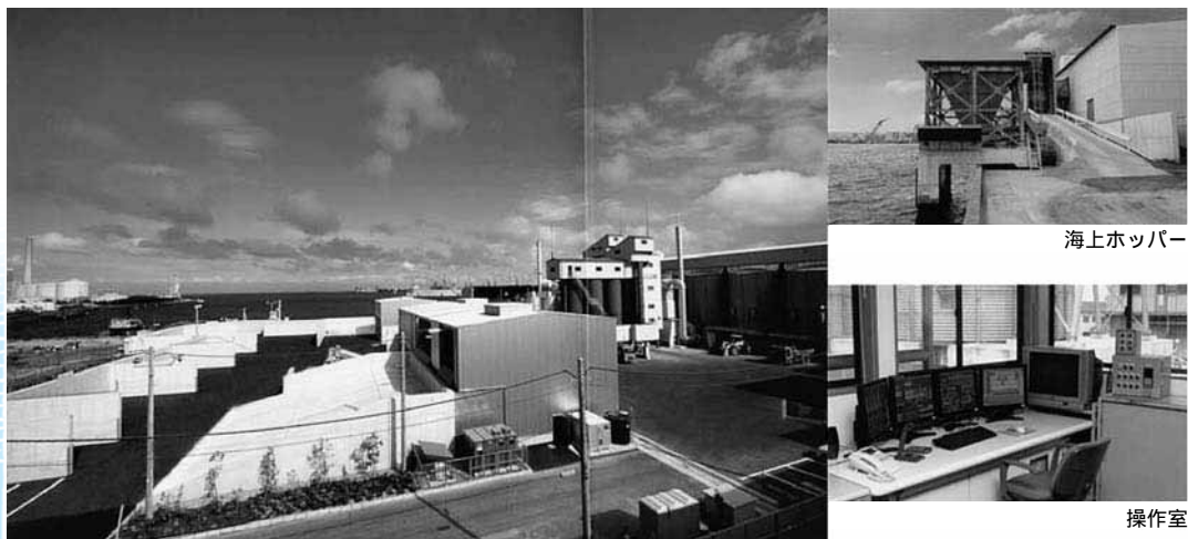
写真1 都市環境型アスファルトプラント（併設加熱混合再生）
