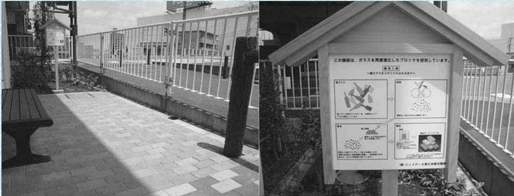
写真5 ガラスカレットを利用した透水性インターロッキングブロックの施工例
