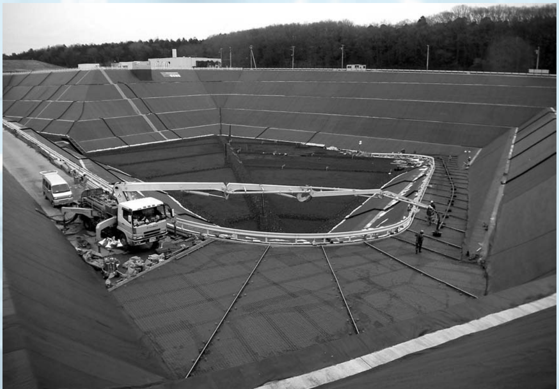
栗本さんが、最近担当した現場（最終処分場でのコンクリート舗装工打設の様子）
