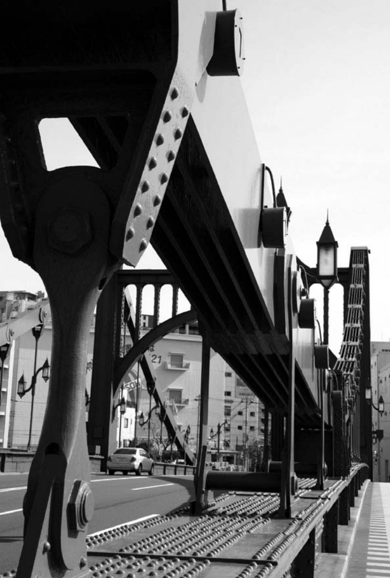
清洲橋のケーブル部分のディテール 自転車のチェーンのように、鉄板でつくられている。 この部分に高張力鋼が使用された。
