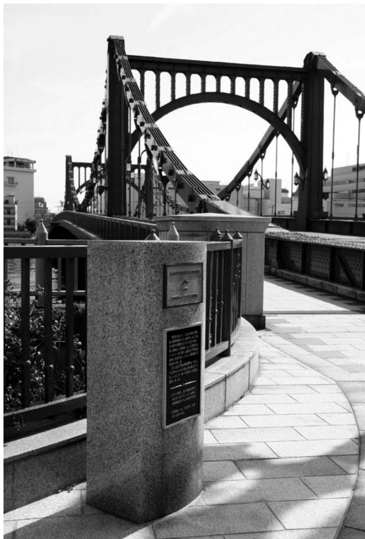
橋の袂にある選奨土木遺産の碑と清洲橋
