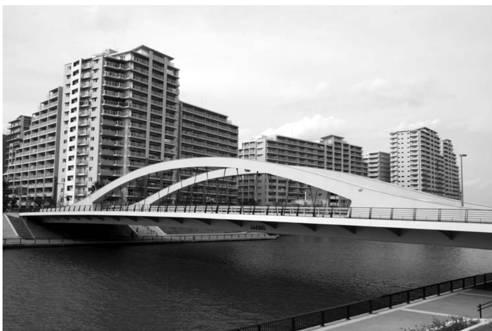
〈新豊橋〉 あたらしい構造デザインの登場 「リビングの中の家具」をイメージしてデザインされたアーチ補剛の箱桁橋。アーチ終端部に橋脚がないのが特徴である。橋長105.0m、幅員16.5m。 (2007年3月竣工)
