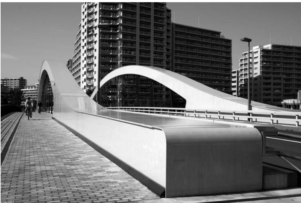
永代橋の現代ヴァージョン？ 永代橋の現代版を想わせる橋上空間。 箱桁からなめらかな曲線を描きながら、 アーチ形状へと移行する。
