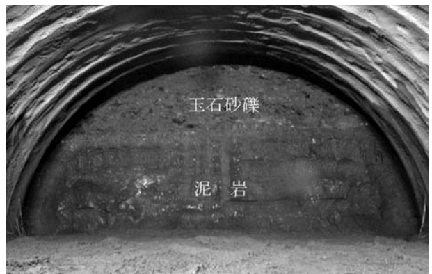
写真3 泥岩と玉石砂礫の地層境界部が出現したトンネル切羽
