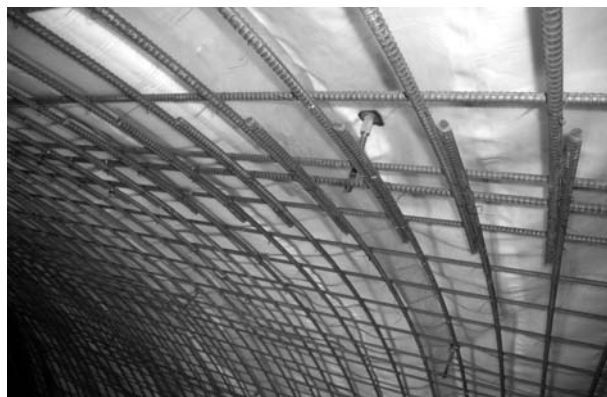
写真4 排水型トンネルのアーチ鉄筋
