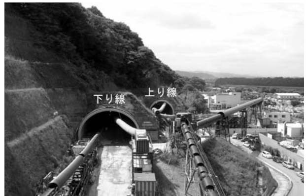
写真2 トンネル坑口の全景
