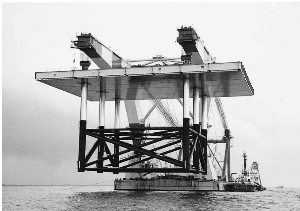
写真4 ● 設置の時を待つジャケット
