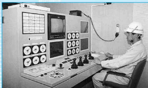
写真1 浚渫ロボットの遠隔操作室
