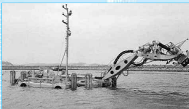
写真2 浚渫ロボットの浮上状況
