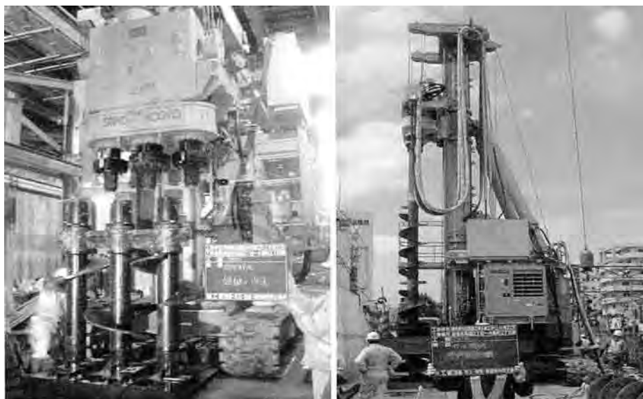
写真●狭隘型SMW機(左:路下型 右:路上型)
