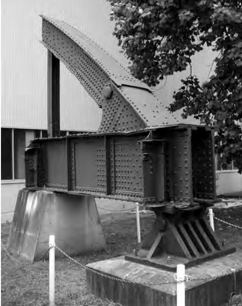
日大船橋キャンパスに展示されている 海幸橋ヒンジ (撮影：伊東孝)
