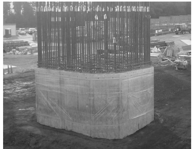
写真4 ●柱部のラッピング養生全景
