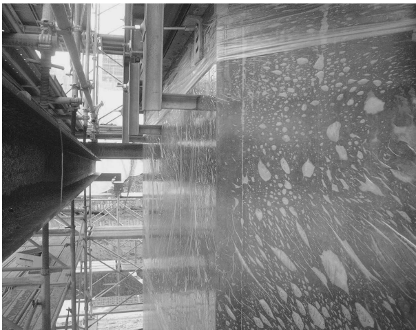
写真3 ●柱部のラッピング養生コンクリートが緻密化・ガラス化する効果がある
