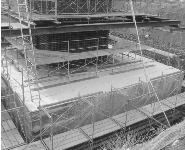
写真1 ●フーチング部のラッピング養生
