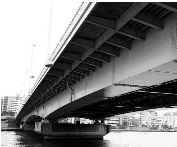
ダイナミックな変断面の佃大橋 箱桁橋、長さ576.3m、幅25.2m、スパン90m、昭和39（1964）年竣工
