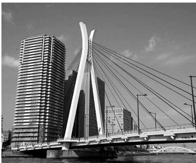
中央大橋の側面景
