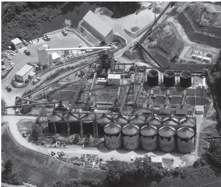
写真3 ● 骨材プラント
