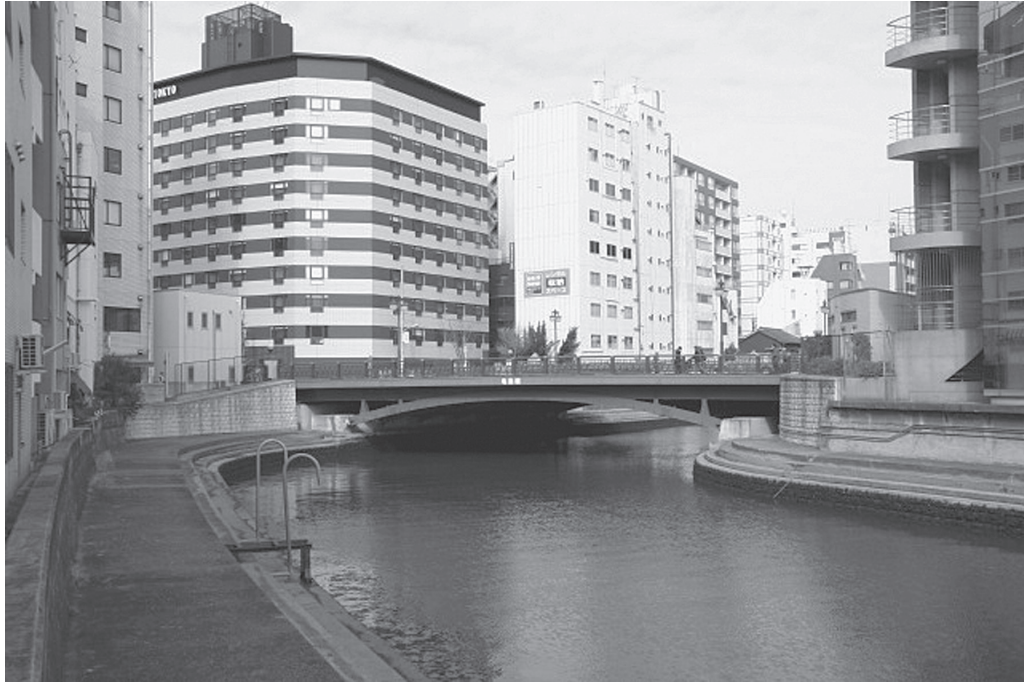
写真1 亀島橋（平成14年6月竣工） 両側は、階段状のテラス護岸
