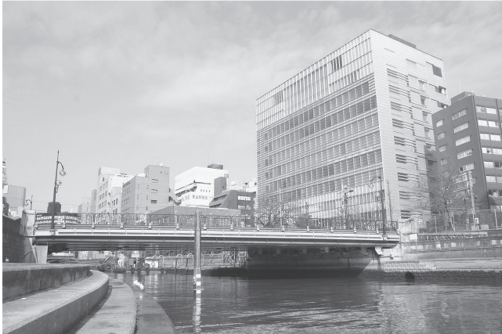
写真2 高橋（昭和58年3月竣工） テラス護岸は、橋下では連続性が確保されていない
