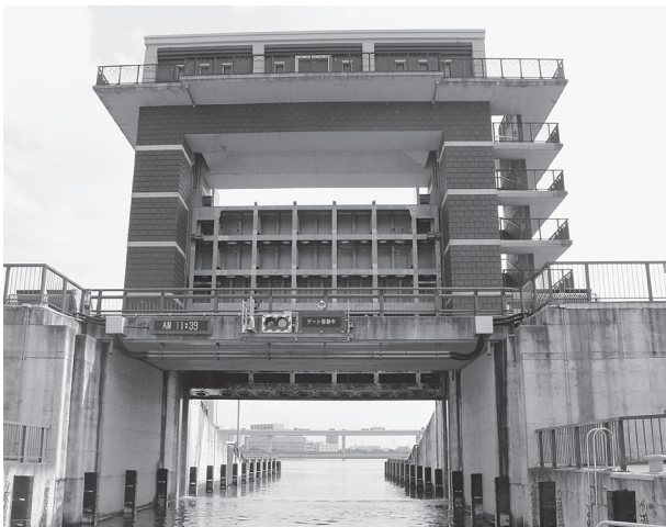
荒川ロックゲート
