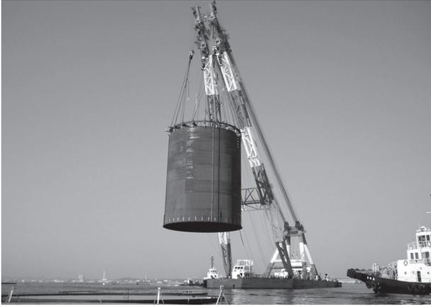
写真2 ● 鋼板セル据付状況
