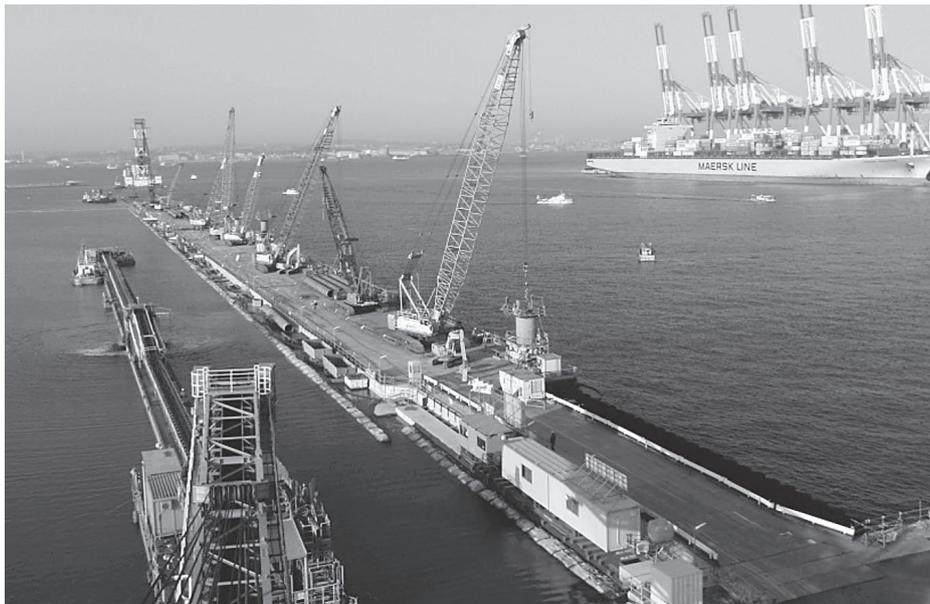
写真6 ● 掘削機配置状況
