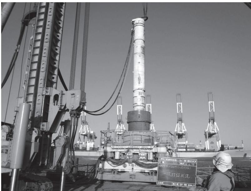
写真4 ● IHC社製油圧ハンマによる杭打設
