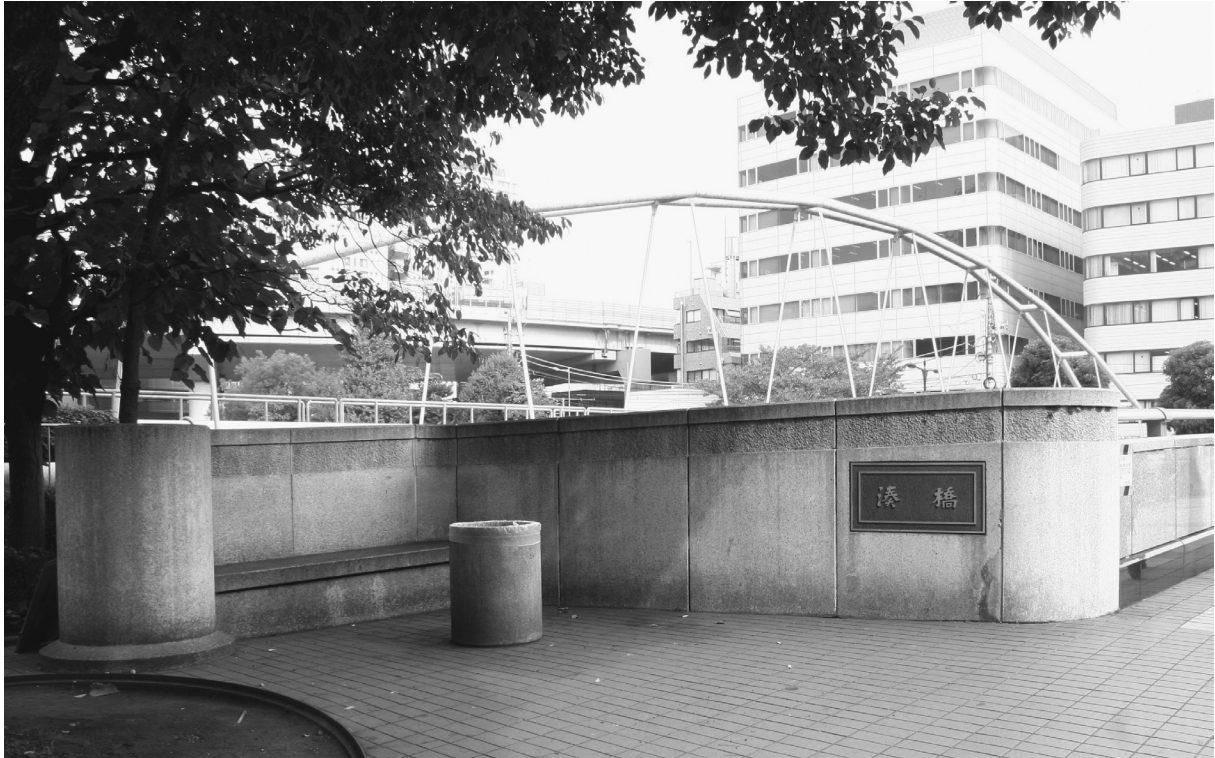
写真3 袖高欄に併設されているベンチ（右岸上流側）
