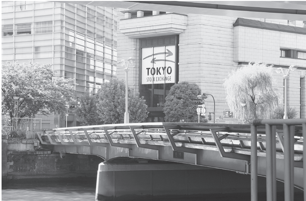
写真1 東京証券取引所見込む鎧橋（左岸下流側から）
