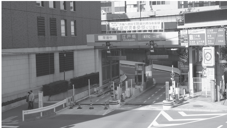
写真4 江戸橋の入口ランプ（右岸上流側）
