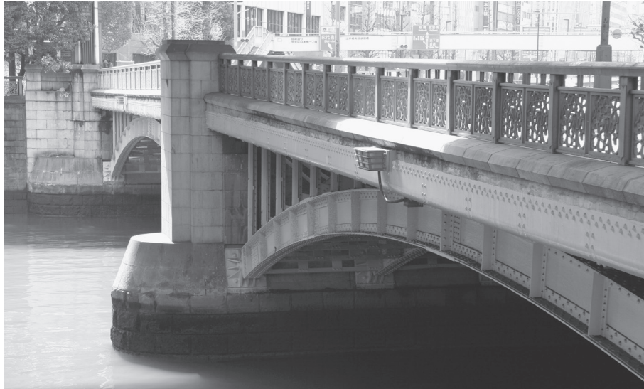
写真3 江戸橋（上流側）
