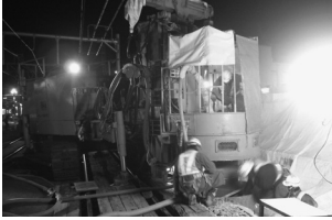
写真5 ● 掘削・排土状況
