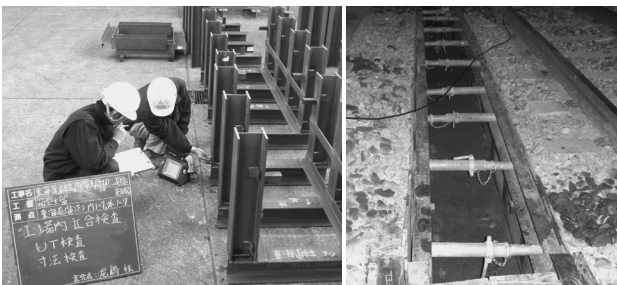
写真9 ● 箱型土留枠
