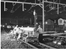
写真8 ● 主桁運搬
