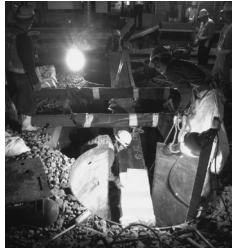
写真7 ● かんざし桁架設
