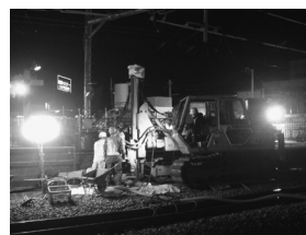
写真1 ●メカジェット施工状況
