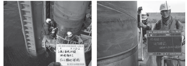
ボルト締付状況 トルク管理状況
