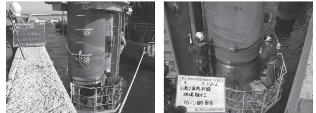
継手継合状況1 継手継合状況2
