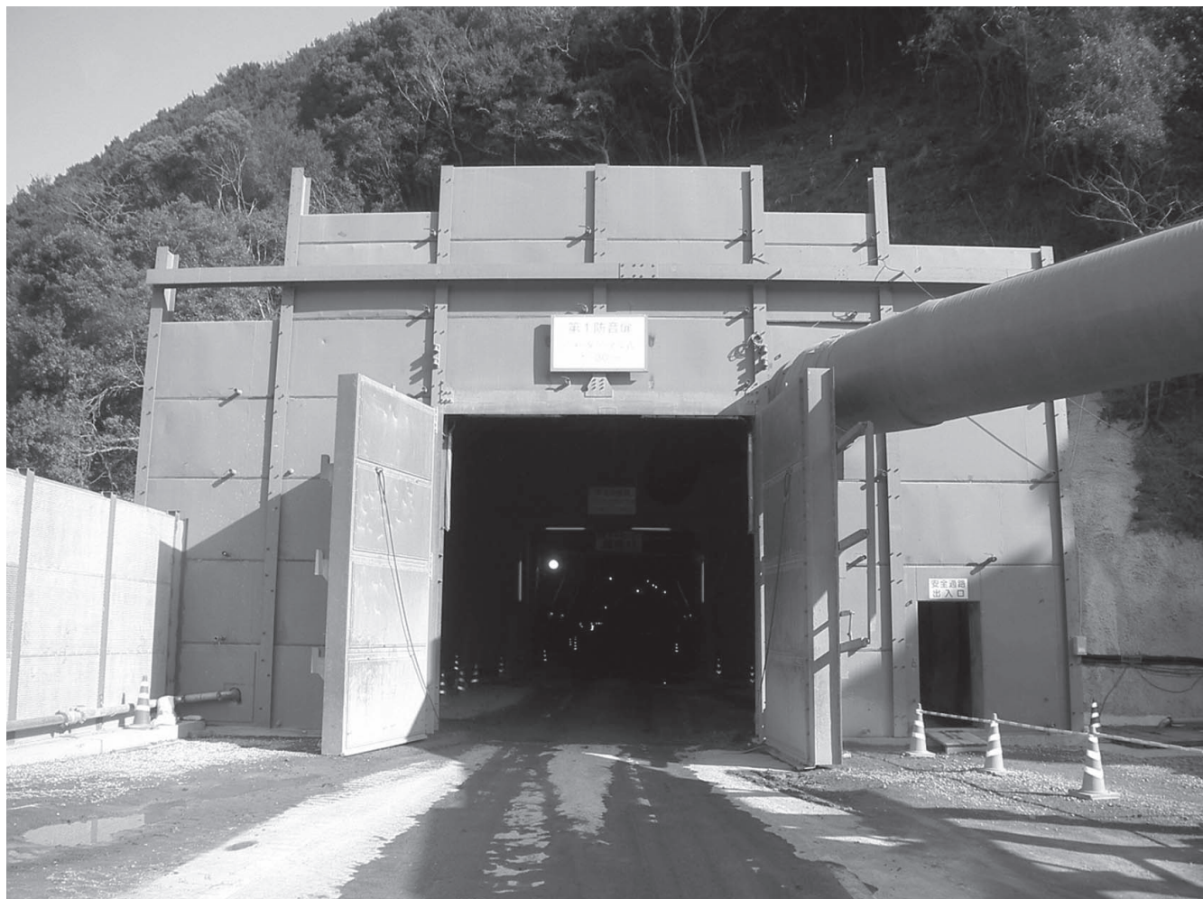
写真-1 防音扉の例
