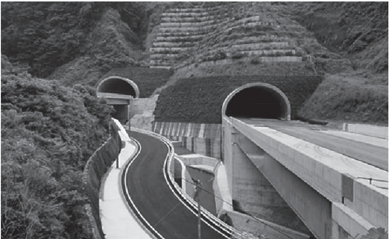
第二東名 富士川トンネル
