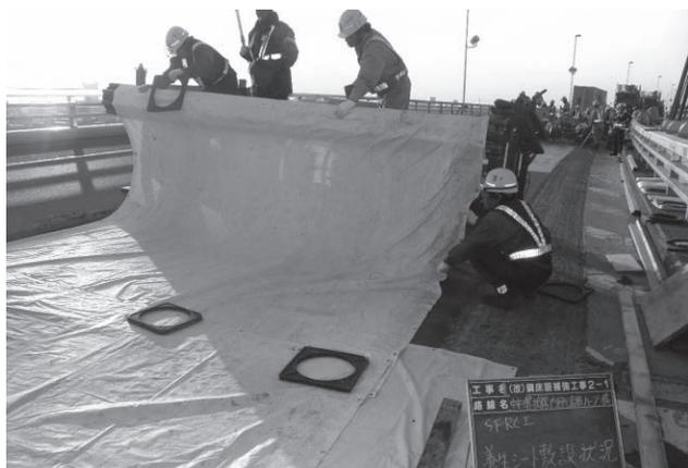
写真-4.6 ロール状養生シートの敷設状況
