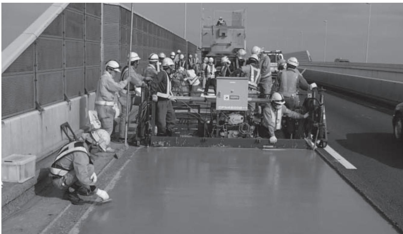
写真-1.1 首都高速中央環状線の鋼床版上面補強工事状況（SFRC打設状況）
