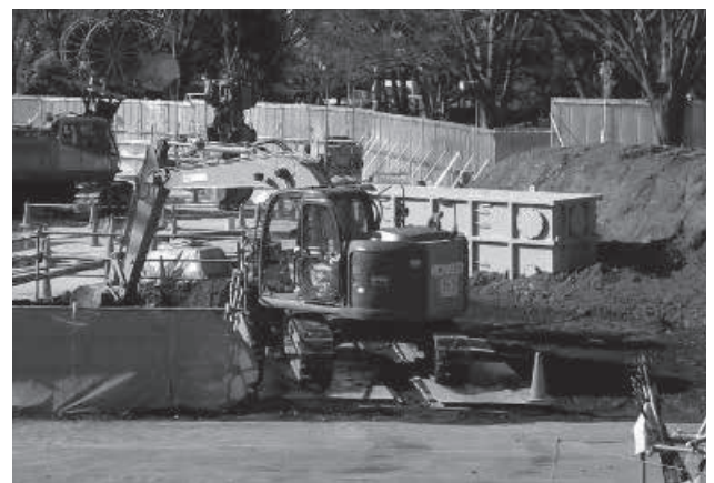
写真-8 セルダンパー敷設
