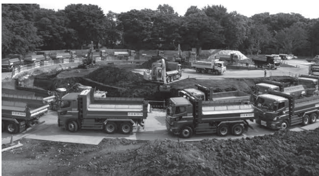
写真-6 土砂運搬ダンプ
