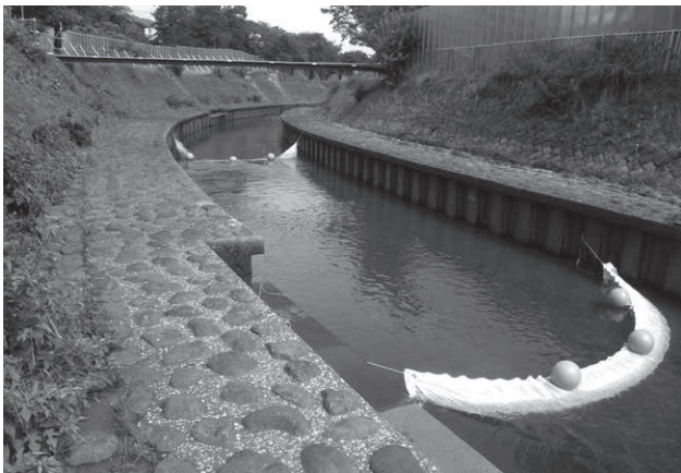
写真-5 シルトフェンス
