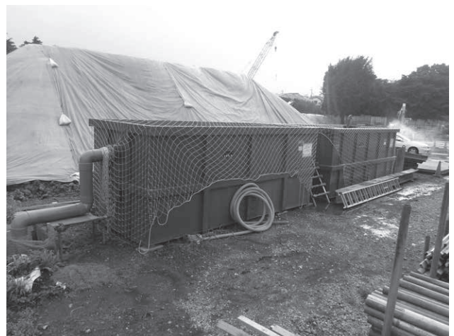
写真-4 濁水処理設備
