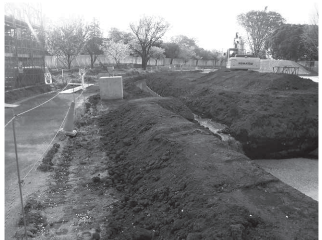
写真-3 土側溝、沈砂池
