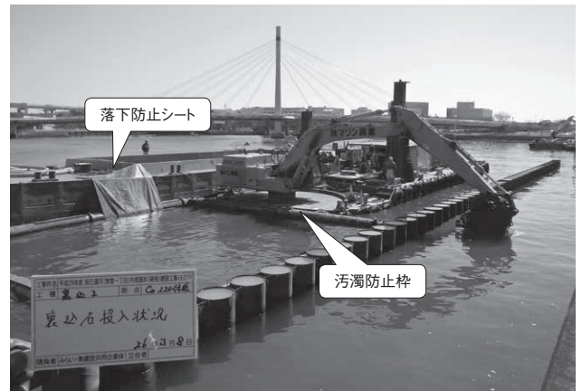
写真-3.2 裏込材投入状況
