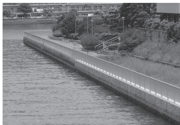
写真-2.2 内部護岸整備後
