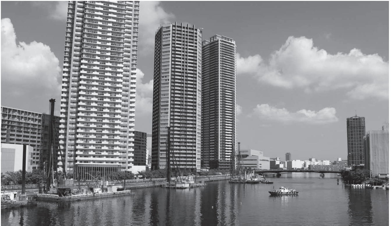
写真-1.1 内部護岸（補強）工事状況
