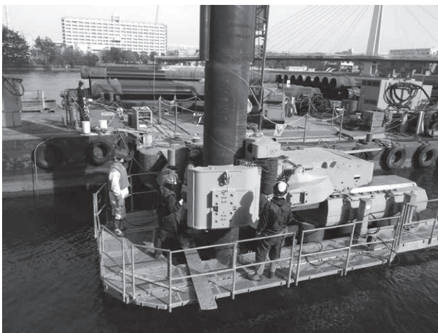
写真-3.1 鋼管矢板打設状況
