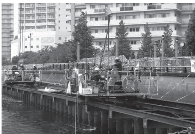
写真-3.3 SMM施工状況
