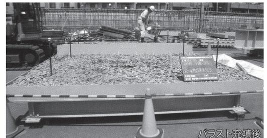
写真-7 鋼製箱桁バラスト充填後写真
