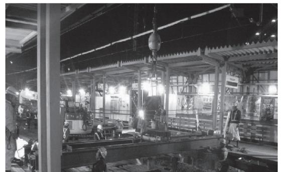
写真-5 スライド&ハング桁設置状況写真
