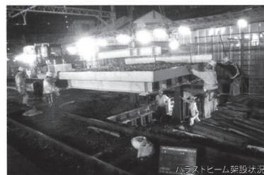
図-10 バラストビーム工法ステップ図及び架設状況写真
