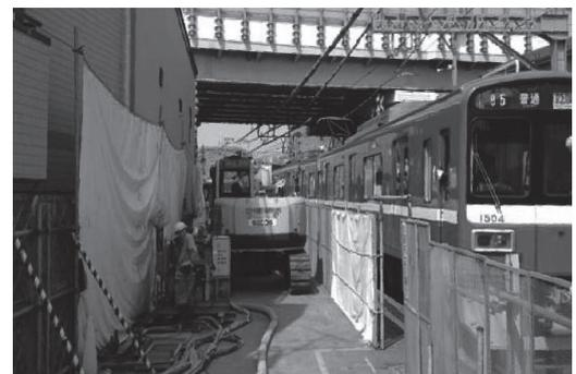
写真-8 Hybrid-BH工法施工状況写真
