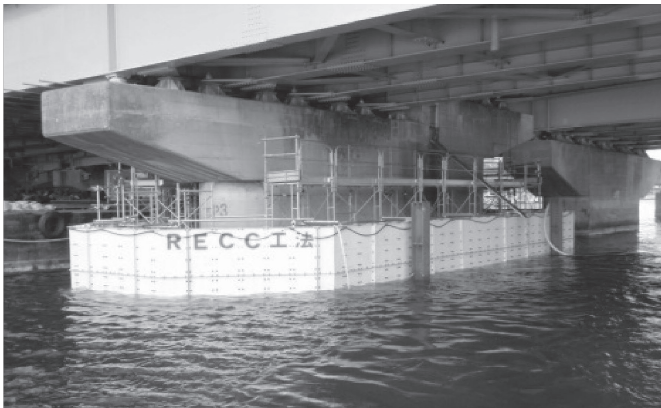
写真-1.1 東京都建設局 春海橋耐震補強工事状況 (RECCI工法)
