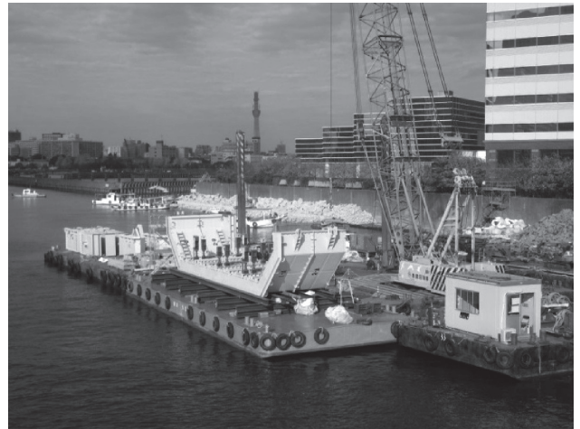
写真-3.2 鋼製函体組立
