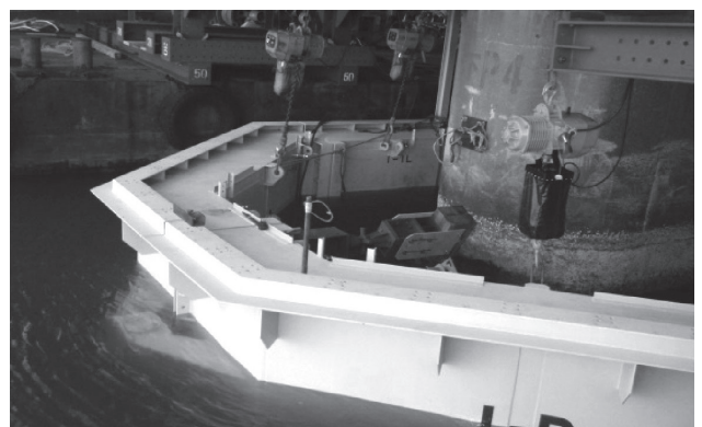
写真-3.3 鋼製函体かん合・沈設
