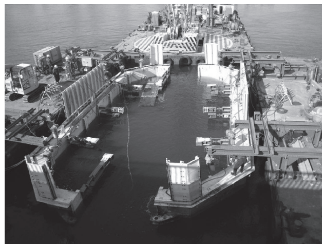
写真-3.6 鋼製函体移動準備・切梁調整
