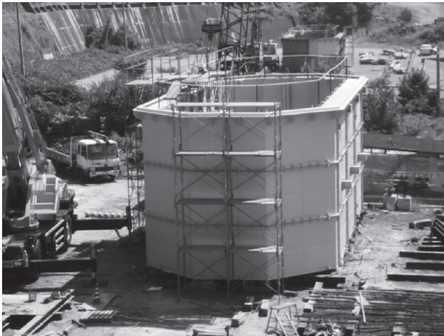
写真-3.1 鋼製函体仮組立
