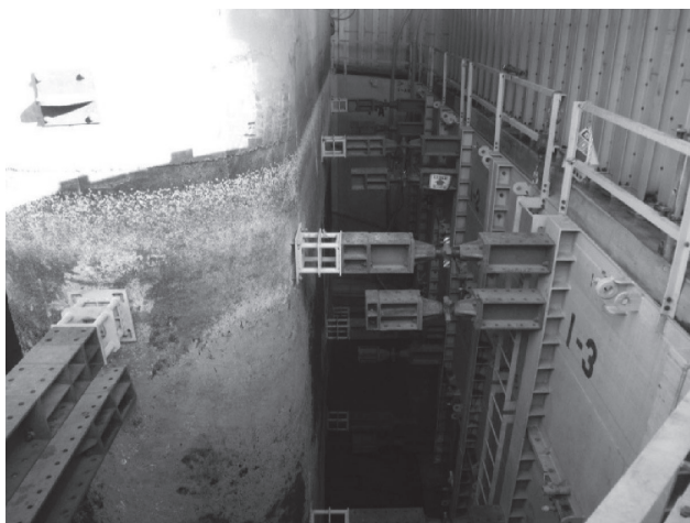
写真-3.4 鋼製函体内排水完了
