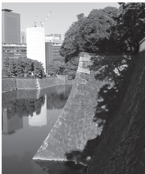
「北桔橋門」は、外部に通じる重要地点であったことから堀が深く、石垣は最も堅牢に築造された。
