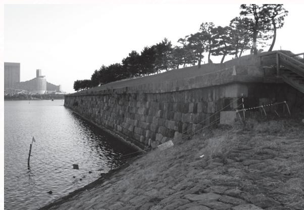
海上で石垣を組み、内部を土砂で埋め立てた。現代の人工島造成の原点とも言える「品川台場」。
