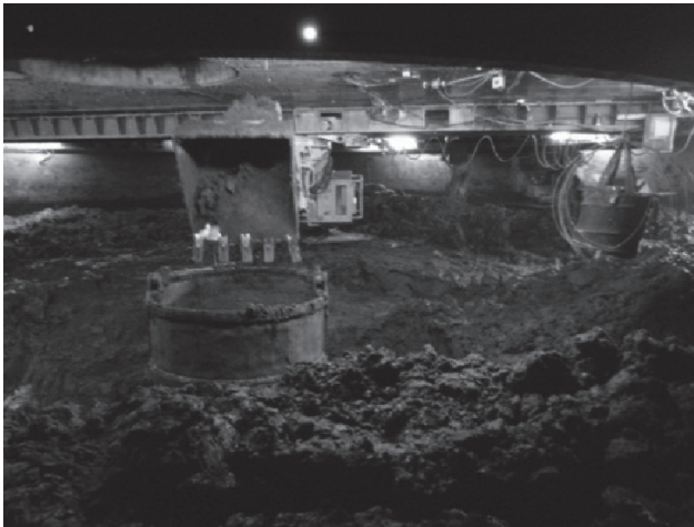
写真-2 函内掘削状況
