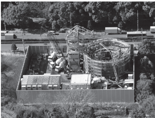
写真-1 立坑全景
