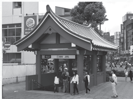
吾妻橋側の浅草駅4番出入口「赤門」は、開通した当時と変わらぬ姿のまま現在も利用されている。
