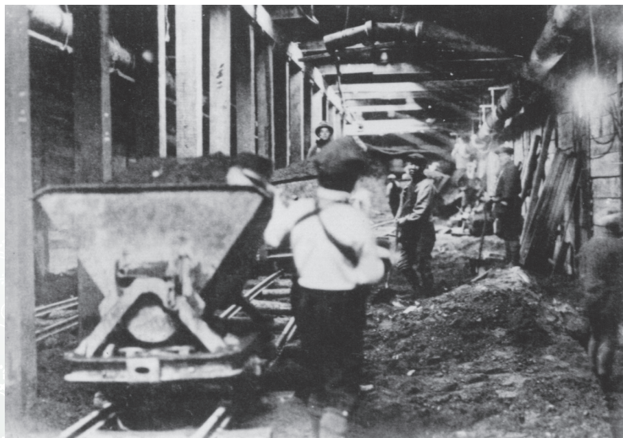
市電が運行しない夜間のわずか3時間で道路を掘り下げ、天井をつくりトンネルとする過酷な工事であった。(提供:東京地下鉄株)
