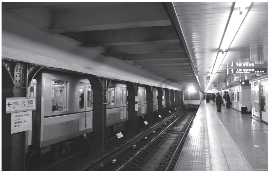
2面2線の対向式ホーム。(提供:東京地下鉄株)
