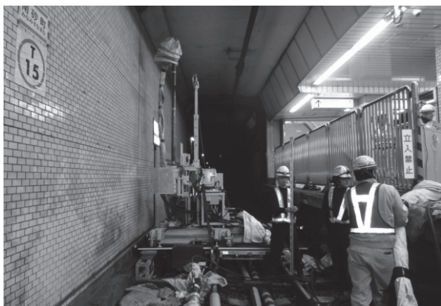
軌道内作業状況
