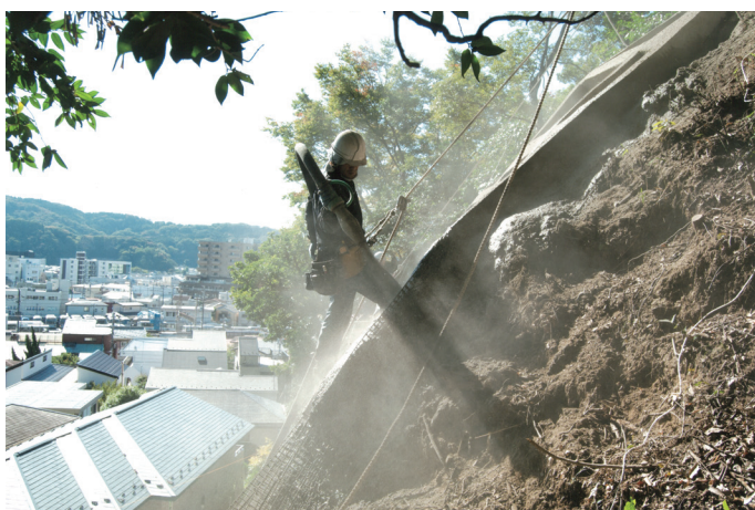
土木工事現場の風景／東京近郊
