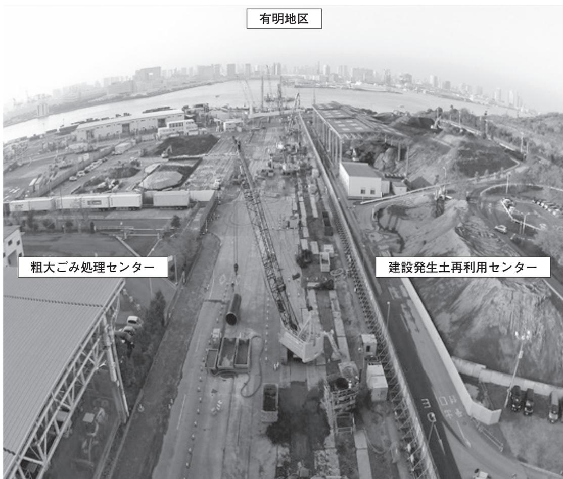
写真-1 置換杭の施工状況
