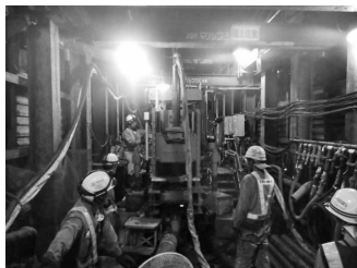
写真-7 路下空間での先行削孔状況
