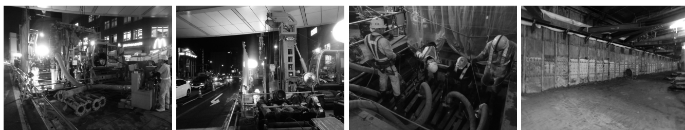
写真-2 削孔状況
