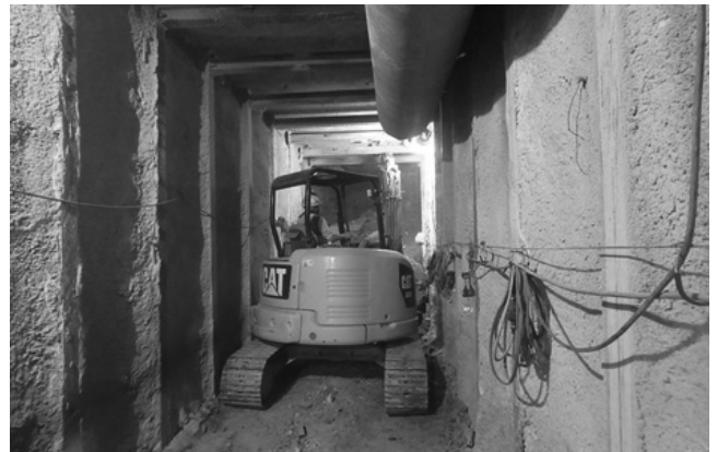
写真-11 躯体下導坑掘削状況
