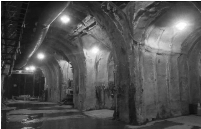
写真-10 連絡導坑・アクセス導坑全景
