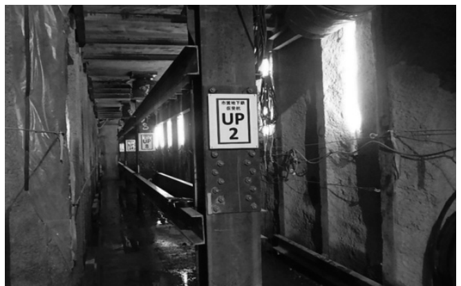
写真-14 仮受け完了状況
