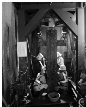
写真-13 杭建込み状況
