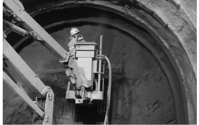
写真-9 吹付け状況
