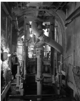
写真-12 削孔状況
