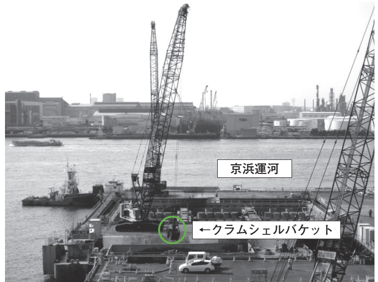
図-13 井筒内掘削状況
