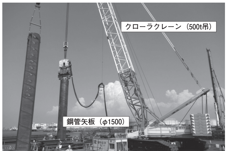
図-11 鋼管矢板打設状況
