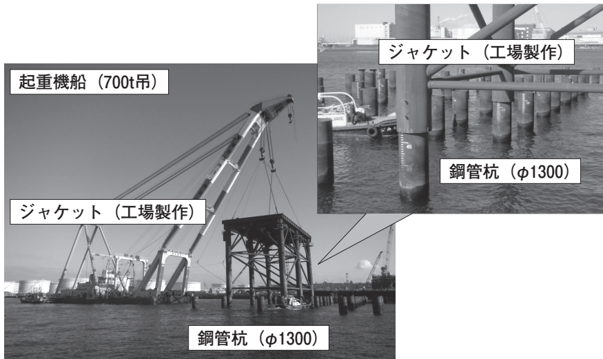
図-7 仮設栈台ジャケット据付
