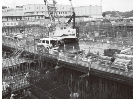
写真-3 置構台設置状況
