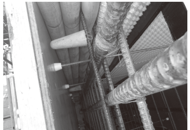
写真-4 施工継手型枠設置状況
