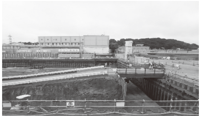
写真-2 仮栈橋設置状況
