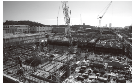
写真-6 現場全景
