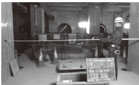
図-11a. ポンプ室計測状況（従来計測）
