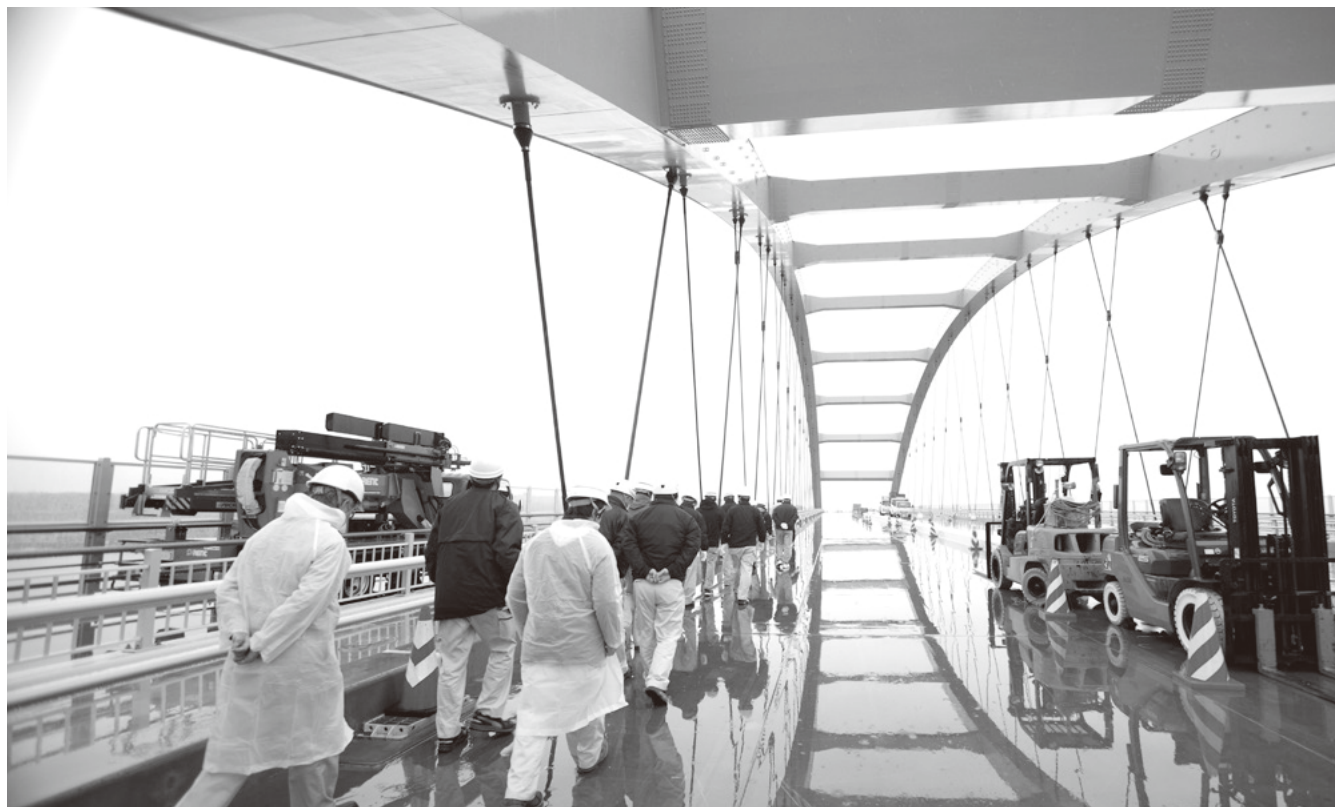
見学会の目玉となったニールセンローゼ橋「東西水路横断橋(仮称)」
