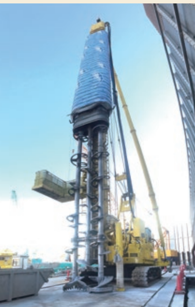
本工事のために開発された 特殊な柱列式中連続壁機
