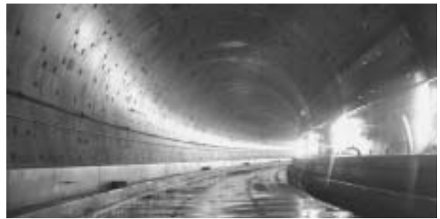
写真3 坑内完成写真
